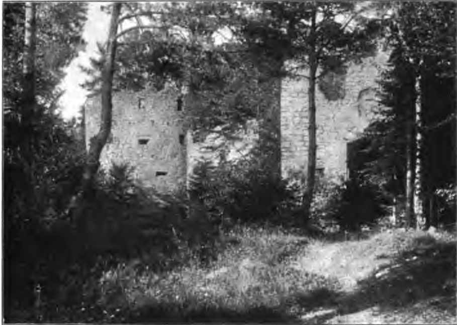
Fig. 48. Kürnberg. Westansicht der Burgruine, Eingangsseite.
